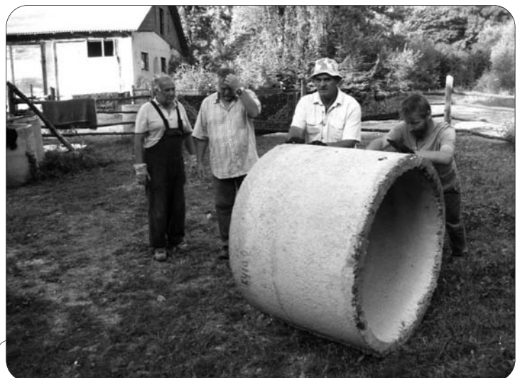
HÄNDISCHES Verlegen der Kanalrohre
